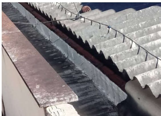
Figura 19 – Detalhe da calha externa da cobertura
