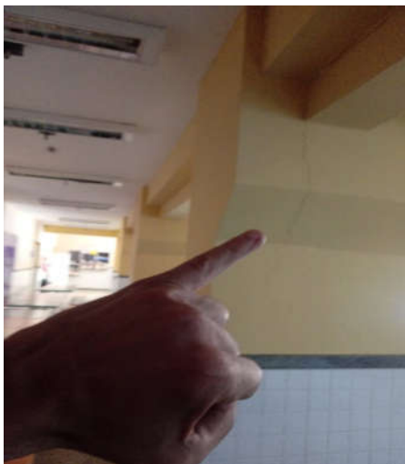
Figura 22 - Trincas no refeitório/corredor devido à acomodação da estrutura após a ampliação (alinhadas às trincas observadas na cozinha – sentido da viga longitudinal)
