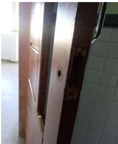
Figura 13 – Problemas com fechaduras – salas de aula
