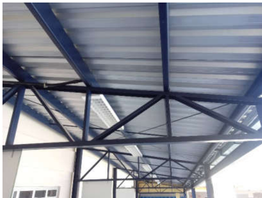
Figura 15 – Estrutura Metálica da cobertura – corredor anexo (1º pavimento)
