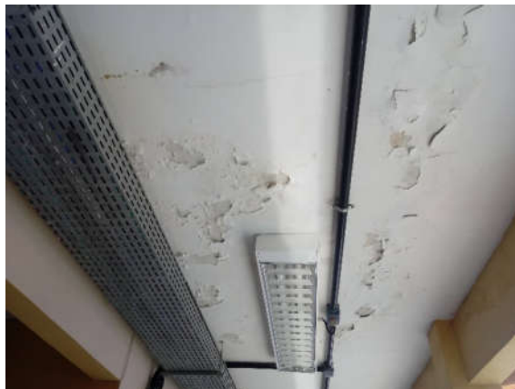
Figura 9 – Corredor do 1º pavimento – problemas de infiltração na cobertura (parte interna)
