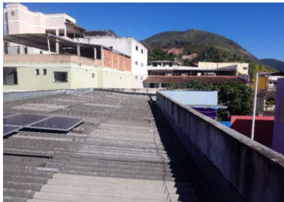
Figura 18 – Vista geral da cobertura
