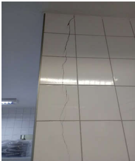
Figura 21 – Trincas na cerâmica da cozinha devido à acomodação da estrutura após a ampliação
