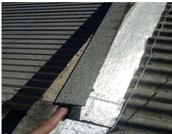
Figura 20 – Chapim de granito da platibanda da cobertura se soltando
