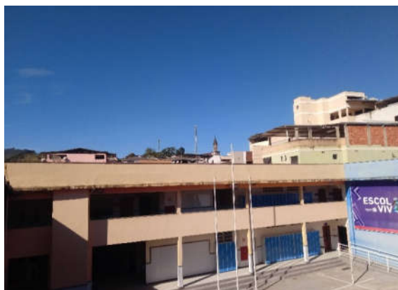
Figura 14 – Vista geral da cobertura para o pátio
