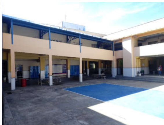
Figura 3 – Vista do pátio
