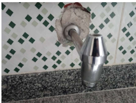
Figura 17 – Detalhe da torneira - banheiro masculino (1º pavimento)
