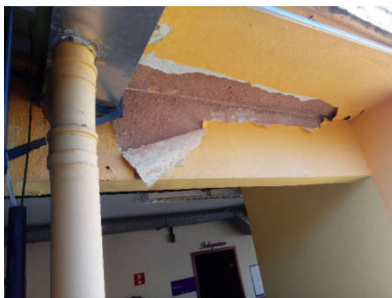
Figura 11 - Corredor do 1º pavimento – problemas de infiltração na cobertura (parte externa)
